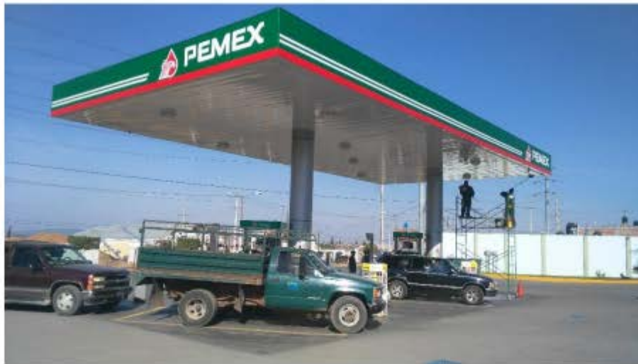
Figura 81. Estación de Servicio para almacenamiento y expendio de diésel y gasolinas ubicada en el municipio de Valle de Santiago (Coordinación Municipal de Protección Civil, n.d.).
