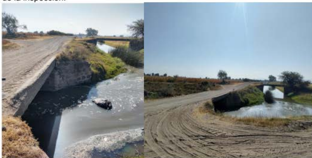
Figura 64. Recorrido de inspección a Zonas de Peligro y Riesgo por Inundación en Dren Garitón, localidad los Pinos, Valle de Santiago, Gto. Fuente: (CEPC, GTO)
