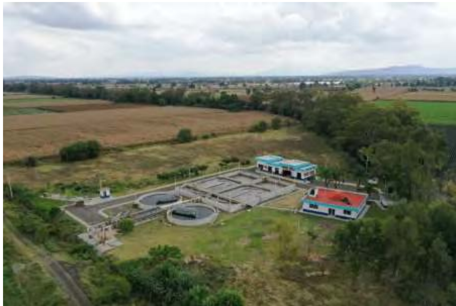
Figura 85. Planta de Tratamiento de aguas residuales de Valle de Santiago.
