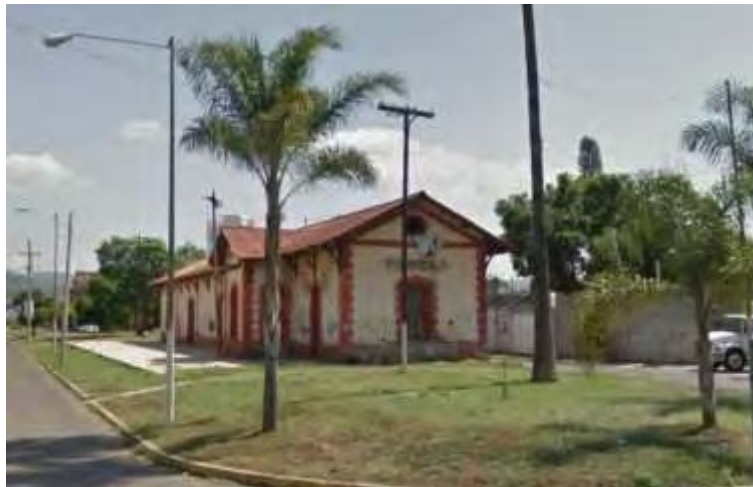
Figura 100. Ex-estación ferroviaria Fuente: archivo fotográfico
